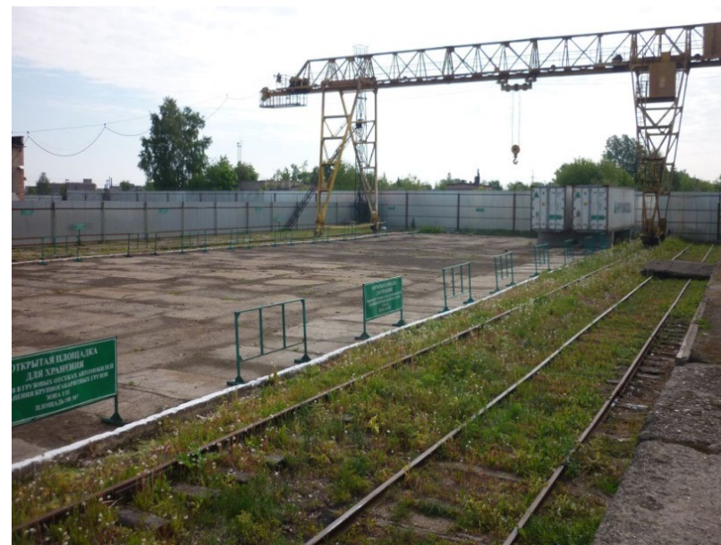
Контейнерная площадка для приема 200 крупнотоннажных Ж/Д контейнеров
